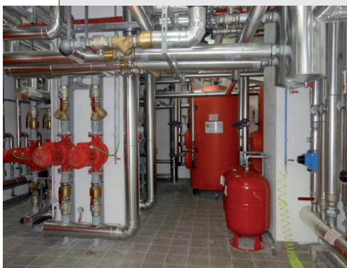
LA CENTRALE dell'ACS.
