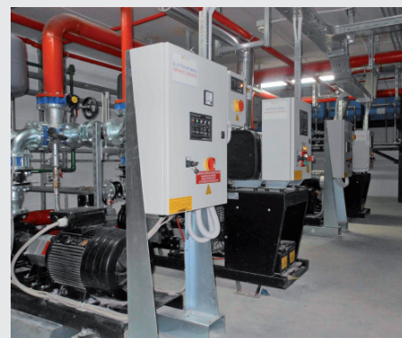
LA CENTRALE antincendio.
