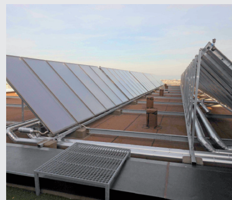
L'IMPIANTO solare termico.
