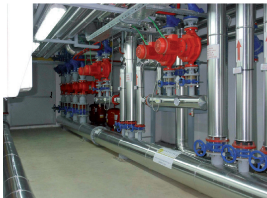
LA DISTRIBUZIONE in centrale termica.
