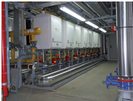
LA SECONDA BATTERIA della centrale termica, raffigurante 8 caldaie Immergas Victrix 115.
