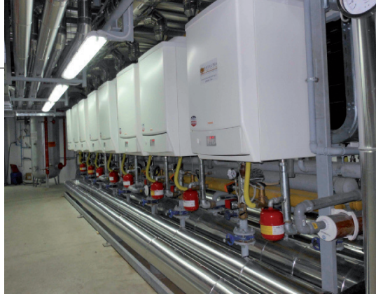
LA PRIMA BATTERIA della centrale termica, raffigurante 8 caldaie Immergas Victrix 115.
