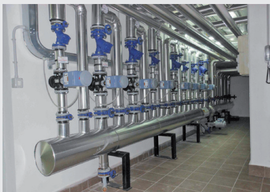
IL COLLETORE nella sala delle unità di trattamento aria.
